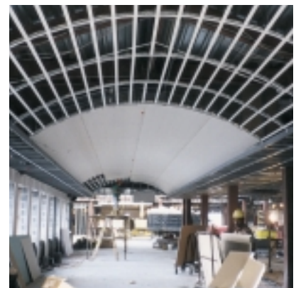
Instalación de Bóveda Barril
