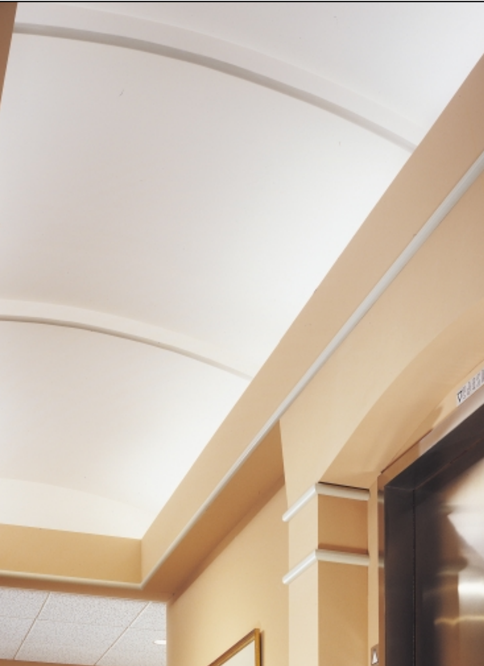
Bóveda Barril con Sistema de Suspensión para DRYWALL (Lámina de Yeso)
